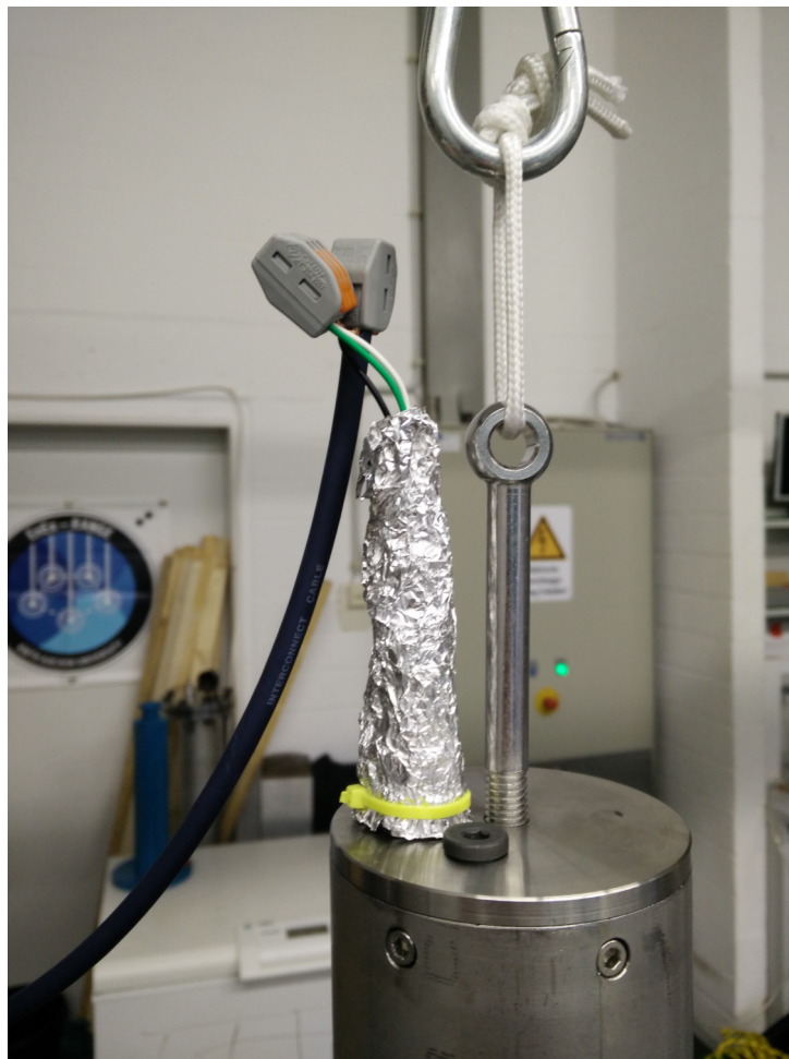
Abbildung A.6.: Schirmung des Steckers an der APU mittels Aluminiumfolie: Der Kontakt zum Ground wird hergestellt, indem mit dem Kabelbinder die Aluminiumfolie an die geerdete Hülle der APU gedrückt wird. Oben steht zur Veranschaulichung noch ein Teil der Kabel frei, auch dieser wird mit Aluminiumfolie geschirmt.
